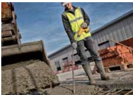
Akku-Betonverdichter DCE531N: Leichte Handhabung
